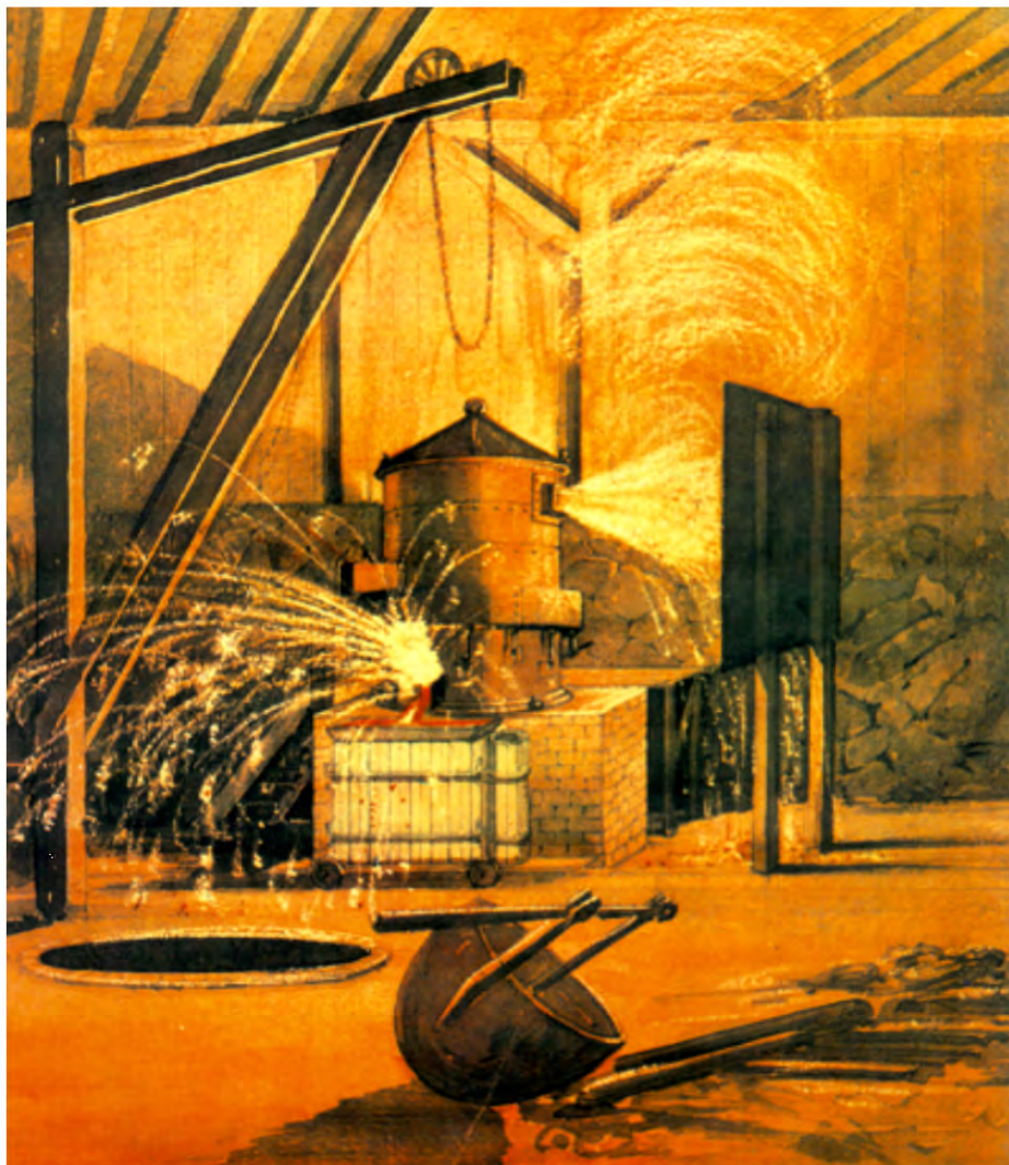
Figur 6. Bessemerblåsning i Edsken 1858. Akvarell av Carl Fredrik August Cantzler, Jernkontorets bildsamling.
