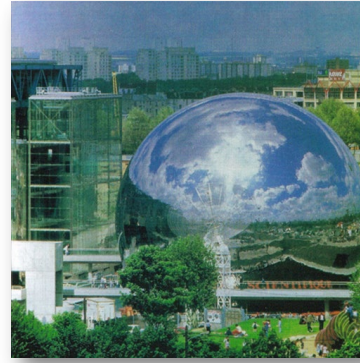
Muséet för vetenskap och teknik, Paris Diameter 30m 1,5mm högglanspolerad 1.4301
