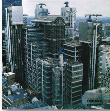
Lloyds building, London Uppförd 1978-86 1,5 mm rostfritt 1.4301 (304)
