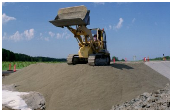
Hytt sand, som tillverkas av masugnsslagg, kan med fördel användas vid vägbyggnad, då markförhållandena kräver en lätt och stark väggkropp. Källa: Merox
