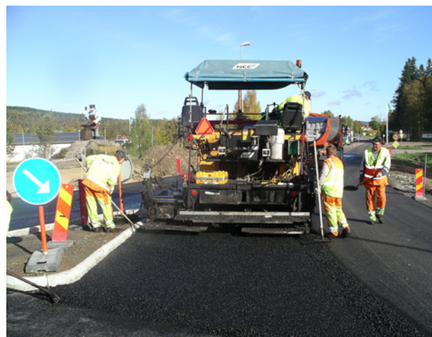
Slaggasfalt med slagg från en av Ovacos ljusbågsugnar. En av fördelarna med slaggasfalt är ökad hållbarhet.
