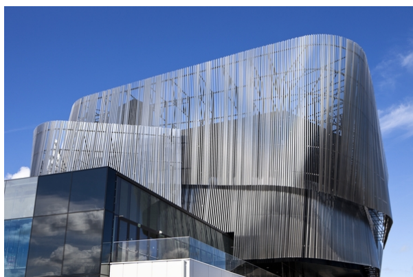
Fasaden på kongresscentret Stockholm Waterfront är tillverkad av rostfritt stål från Outokumpu. Foto: Outokumpu.
