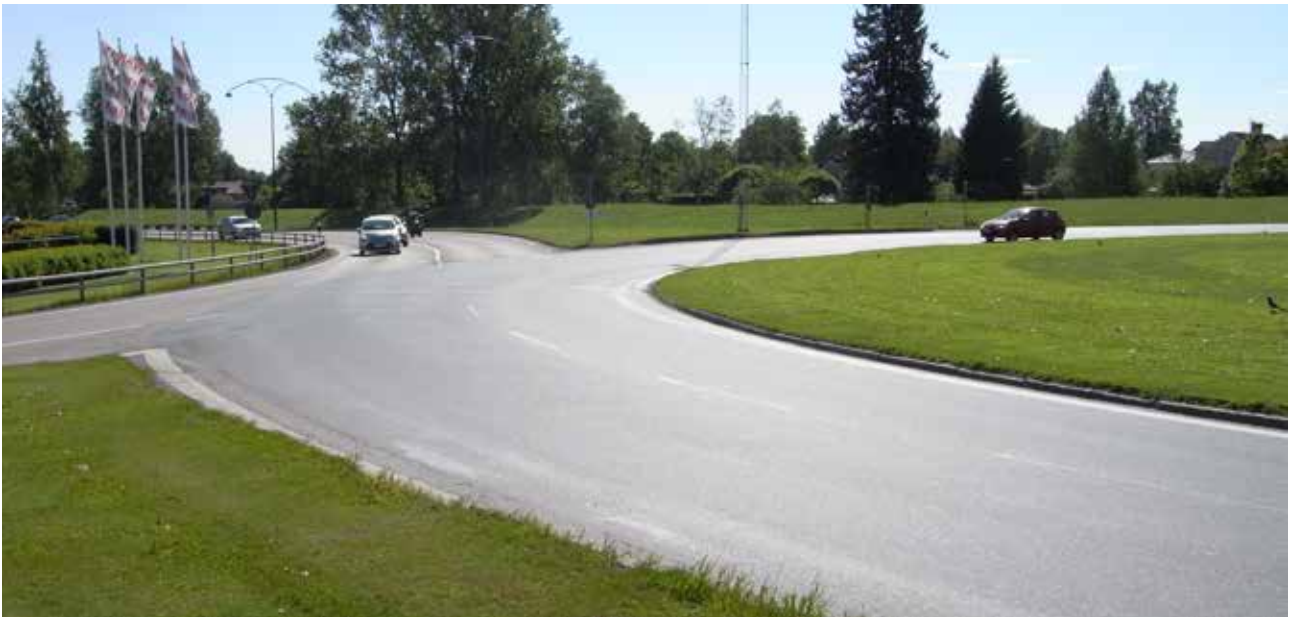
Grådarondellen i Borlänge. När stålslagg används som ballast i asfalten blir vägbanorna hållbarare och livslängden ökar. NCC och Ovako har tecknat ett tioårigt kontrakt där slagg från Ovako ska bidra till bättre vägar. Bildkälla: NCC, foto: Rickard Eskelund.
