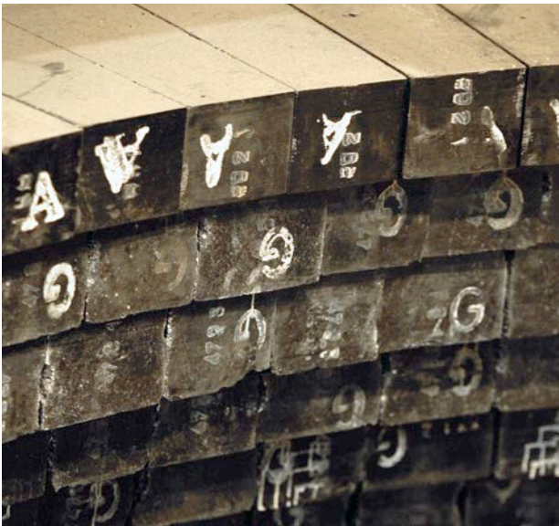
Eldfast material i en nymurad LD-konverter. Teknikområde 23:s omfattande verksamhet är indelad i fyra forskningsblock, varav ett driver forskning om konvertermetallurgi och ett annat fokuserar på sådant som har med eldfast teknik att göra. Foto: Stig-Göran Nilsson.
