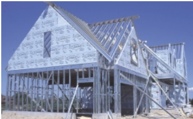
Byggnad av ett miljöanpassat hus med stål, s k lättbyggnad.
