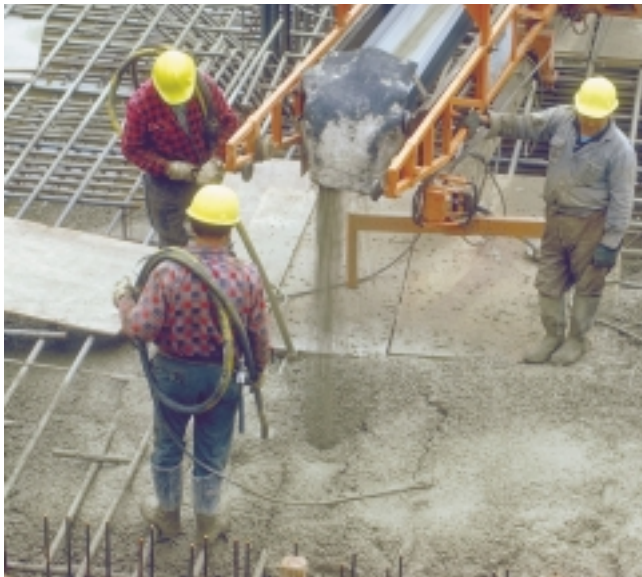
Gjutning av stålarmerad betongbyggnad.
