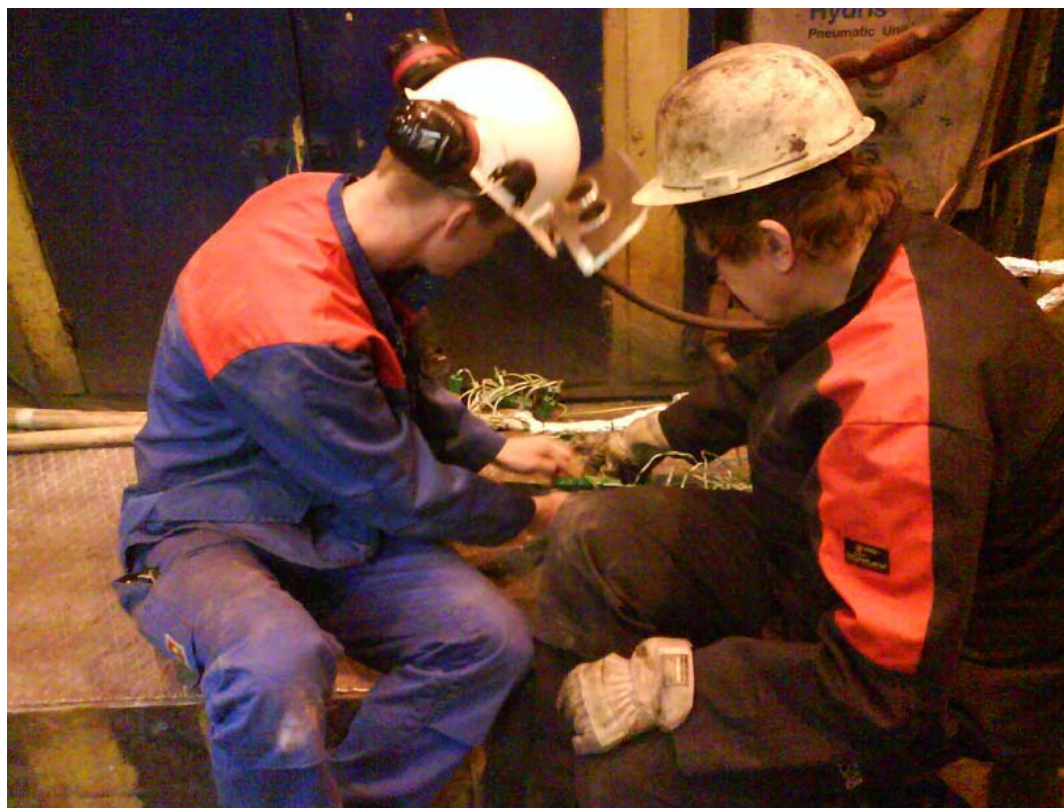
Figur 4. Tomas Sohlgren och Anders Lagerstedt från SSAB Plate monterar kompensationskablar i samband med valideringsförsöket.
