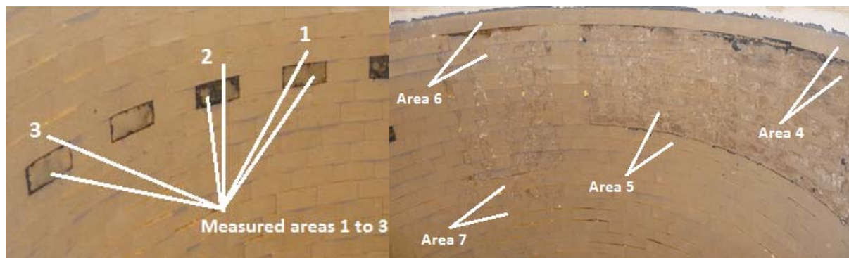
Figur 16. De olika positionerna för mätning av avkolningsdjup.
