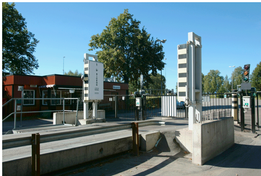
Fast installation för kontroll av radioaktivitet hos inkommande gods.
