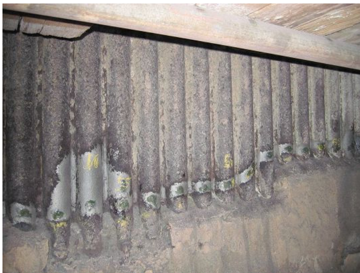
Figur 6. Bilden visar en vattenvägg i en av Renovas pannor. Det är bara ena sidan av panelväggen, insidan, som exponeras mot de korrosiva rökgaser vilka bildas vid förbränningen av soporna. I bildens nederdel syns de med kiselkarbidmassa skyddade kolstålsrören. Kiselkarbidmassan skyddar mot korrosion men minskar samtidigt värmeöverföringen. Ovanför massan syns de oskyddade kompondrören, efter i detta fall 4 års drift.
