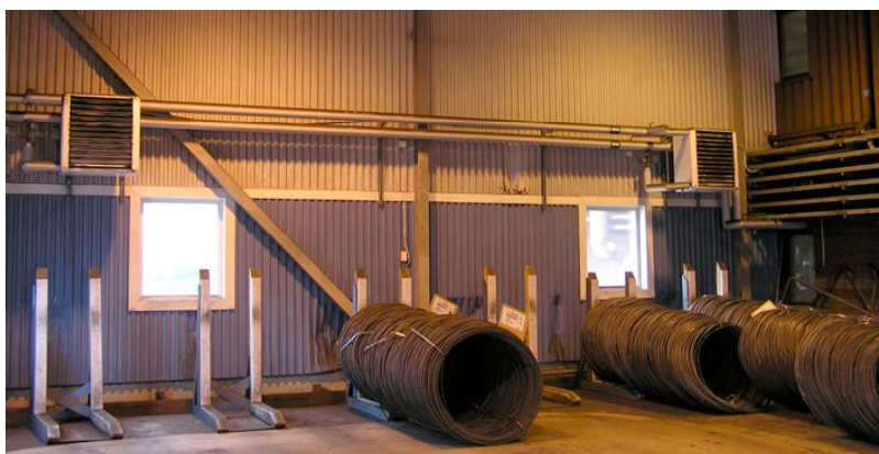
Beredningshallen med trådringar och aerotemperar på väggen. Foto: S-E Storbjörk
