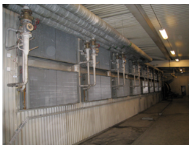
Hetvattenbatterier för luftvärmningen.
