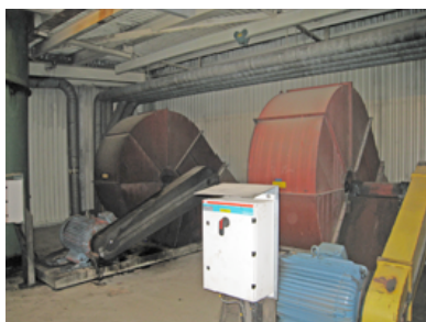
Två, av fyra, fläktar för motorkylningen.
