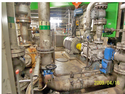
Motorer och pumpar i 70-bars systemet
