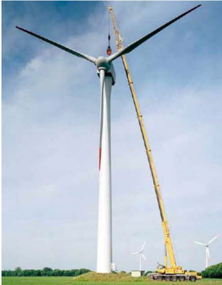
Figur 53. Weldox 1100 används i kranarm och stöbben på en mobilkran, SSAB
