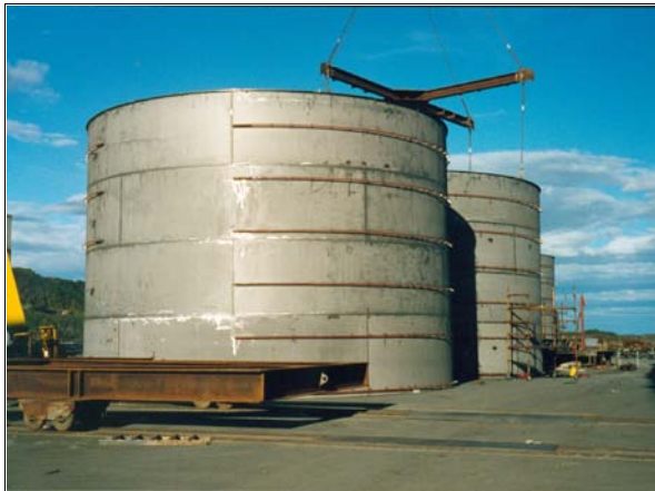
Figur 55. Tank i duplex rostfritt stål LDX 2101 ger 33 % lägre vikt än konventionellt stål, Outokumpu
