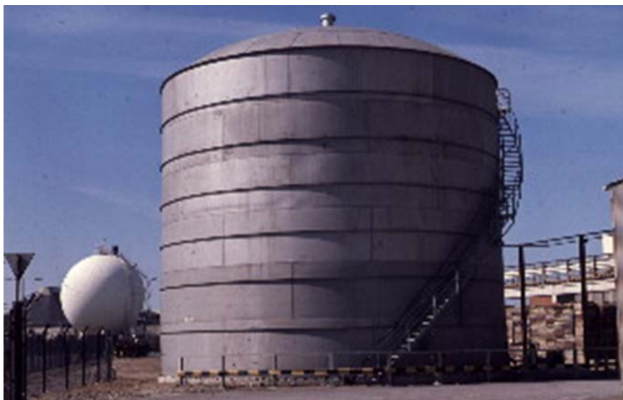
Figur 4.4. Tank i duplext rostfritt stål LDX 2101 ger 33 % lägre vikt än konventionellt stål, Outokumpu
