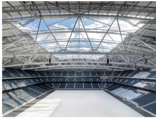
Figur 4.5.a. Takkonstruktionen i Friends Arena är delvis tillverkad i höghållfast stål och vikten har kunnat minska med 584 ton till 4 000 ton.
