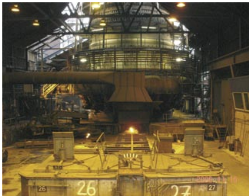
Vid omställningen av Masugn 2 byttes manteln, det gamla kylsystemet med kyllådor byttes ut mot "staves" (kylplattor) och ugnens profil ändrades. SSAB Oxelösund.
