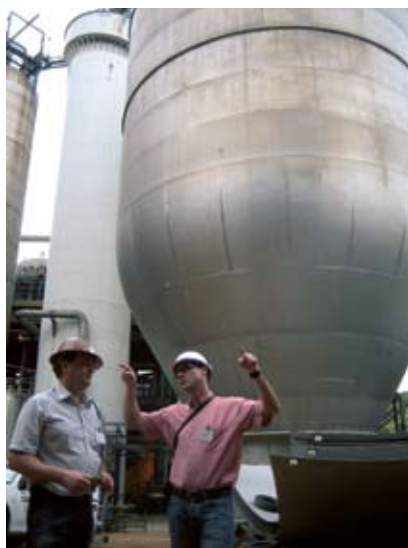
Sulfittkokare tillverkad av plåt från Outo-kumpu och beställd av Sappi Saiccor i Sydafrika.
