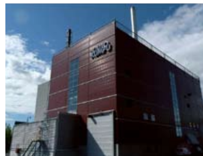
Ny syraåtervinningsanläggning i Avesta.
