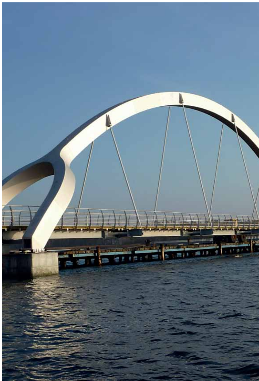
En ny gång- och cykelbro i Sölvesborg. Bågen mäter 60 meter och är tillverkad av rostfritt höghållfast duplexstål, LDX2101, från Outokumpu.
